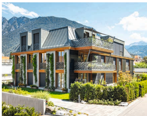
Immeuble à Coire : végétalisation de façade combinée à des modules PV. Photo : Ingo Rasp
